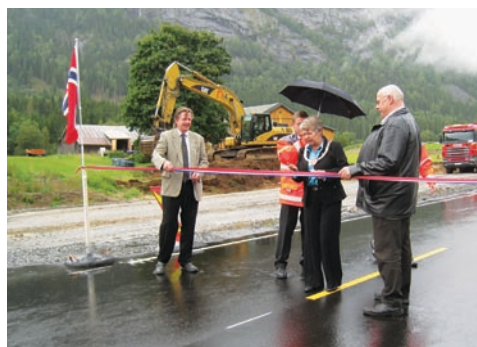
Den 8. september 2008 var det opning av parsellen Ose nord – Tveit. Fylkesordførar Laila Øygarden stod for snorklippinga med god hjelp av styreleiar i Setesdal regionråd, Kay Jeiskelid, og ordførar i Bygland, Knut A. Austad.
